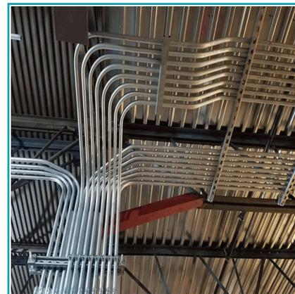
**\*Nombre:** Tubería Metálica Eléctrica tipo EMT de 1 1/4" (Sin UL).
