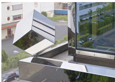
Revestimiento de fachada con acabado recocido brillante antes y después de la limpieza: Las operaciones de mantenimiento estándar devuelven a la superficie altamente reflectante su brillo original. Fotografía: Christian Pohl GmbH, Colonia (Alemania)
