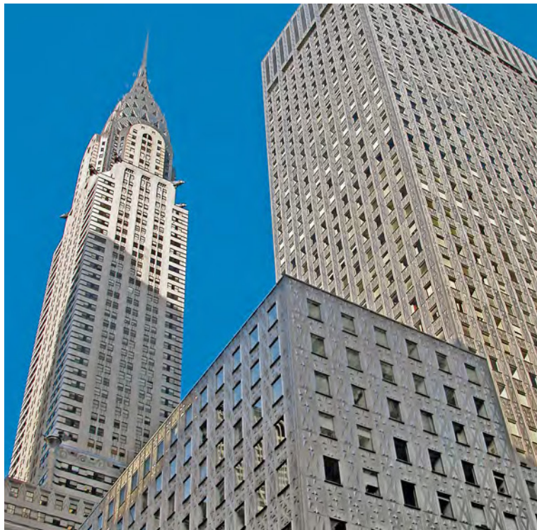
El Edificio Chrysler (izquierda), finalizado en 1930, fue la primera aplicación estructural de acero inoxidable a gran escala. El Edificio Socony Mobil (derecha), de 1956, fue la mayor fachada de acero inoxidable del mundo en el momento de su construcción. Ambas fachadas fueron sometidas a una primera operación de limpieza de la que se tiene noticia en 1995. Fotografía: Nickel Institute, Bruselas (Bélgica)/Catherine Houska, fotógrafa, Pittsburgh, PA (Estados Unidos).
