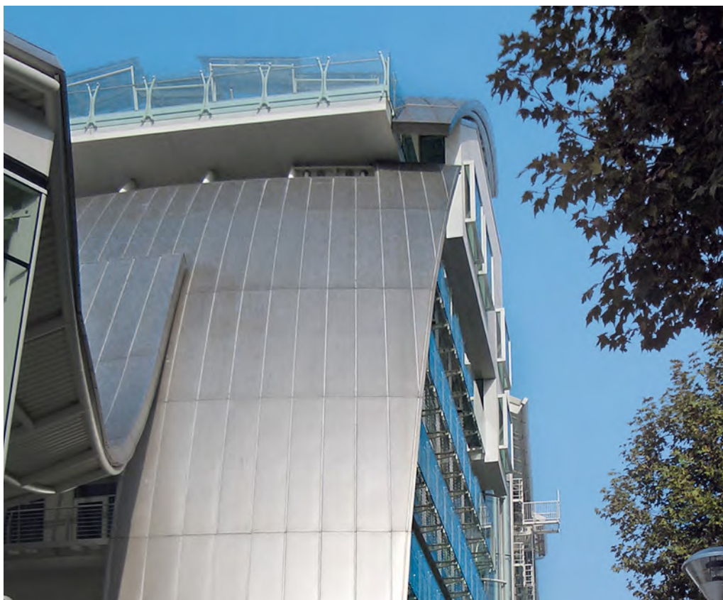
La lluvia provoca un efecto de limpieza natural en las partes de la envolvente del edificio expuestas a los elementos. Fotografía: Centro Inox, Milán (Italia).
